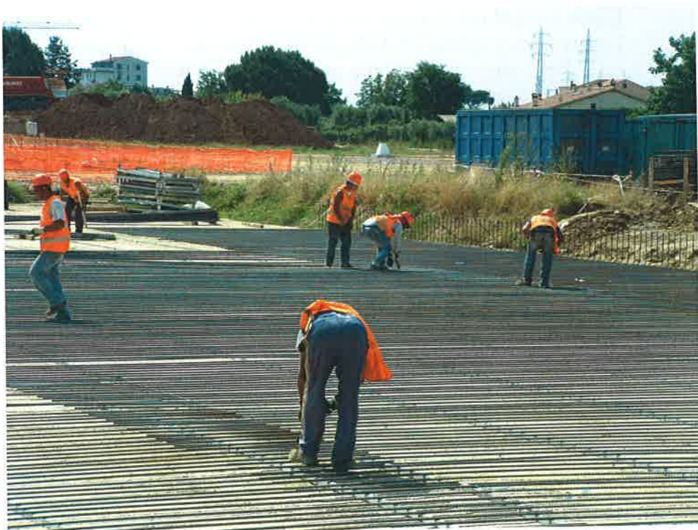
Lavoratori nella posa delle armature di uno dei quattro Nuovi Ospedali Toscani.
